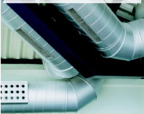
Doppelwandige Wickelfalzhöhre geliefert für das Kernforschungszentrum CERN
