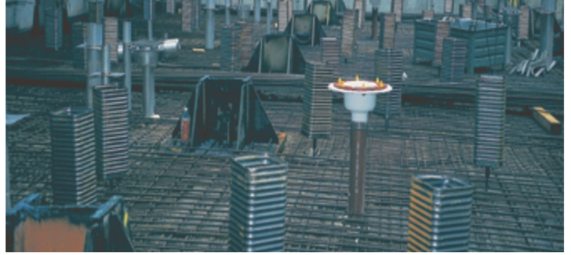
Der Einbau der oberen Bewehrung erfolgte nach dem Einbau der Fundamentköcher. Fundamentköcher 30/30/60 cm mit Höhenverstellung
