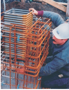
Fundamentköcher 30/30/60 cm mit Höhenverstellung Foundation tubes 30/30/60 cm with height adjustment
