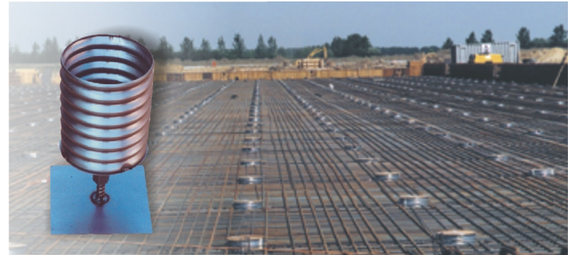
Bodenplatte von einem Hochregallager mit über 900 Stück FKVR und Höhenverstellung Base plate for high-rise warehousing with over 900 FKVR units and height adjustments
