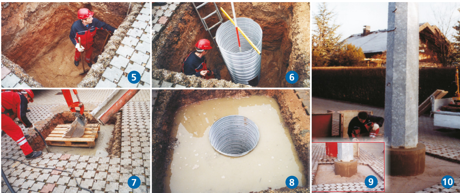
Anwendungsbeispiel: Strommastfundament, Fotos 5 bis 10
