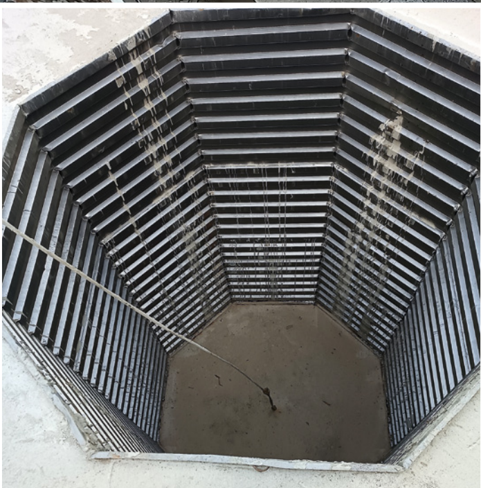
Achteckschalung Octagonal shutters
