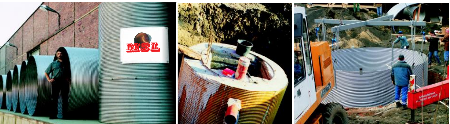
FKR, Durchmesser 1,86 m, als Außenschalung FKR, diameter 1.86 m, as exterior shuttering
