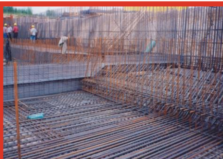
BV: Büropark Unterföhrung Fa. / Company Heilit & Wörner MSL Typ/type SWF02 1800 lfdm/rm
