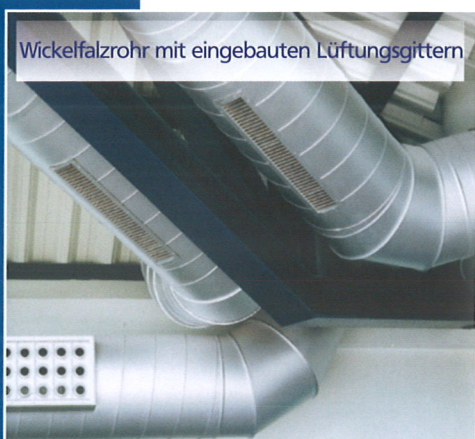
Doppelwandige Wickelfalzrohre geliefert für das Kernforschungszentrum CERN
